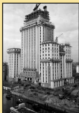
Г. Корабельников. Строительство высотного здания на Котельнической набережной. 1950-е гг.
